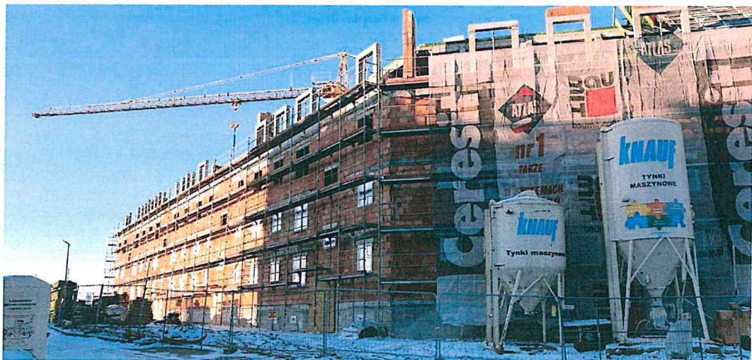
Budowa w trakcie realizacji
