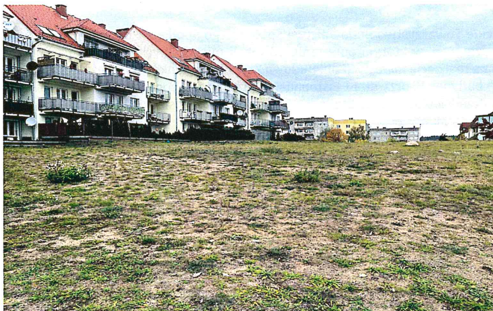
Teren budowy przed rozpoczęciem inwestycji
