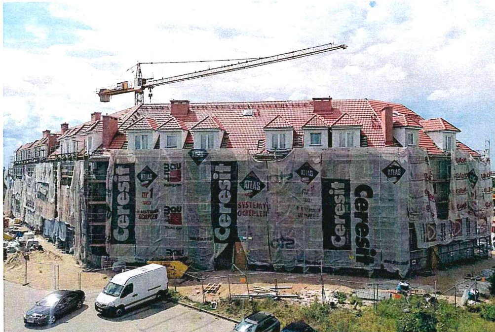
Budowa na obecnym etapie realizacji
